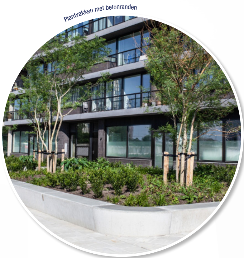
Plantvakken met betonranden
